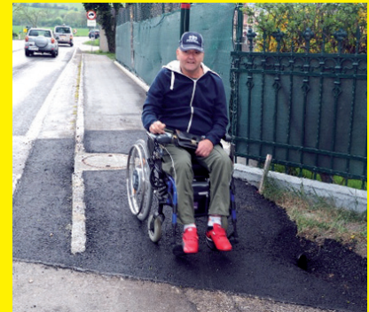
>> Kleine Maßnahmen mit großer Wirkung: Gehsteige wurden abgeschragt.
