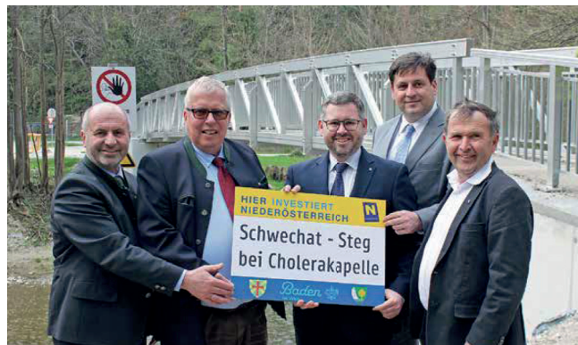
Der Schwechatsteg bei der Cholerakapelle wurde gemeindeübergreifend saniert.
